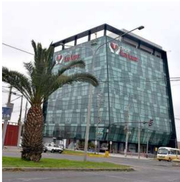
Figura 2: Infraestructura de Clínica La Luz
