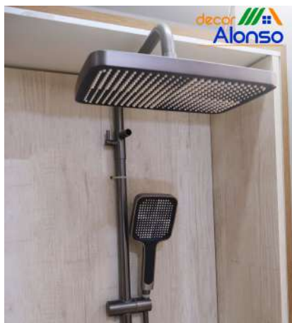
Figura 25: Sistema de Ducha con Rociador Superior y Ducha de Mano
